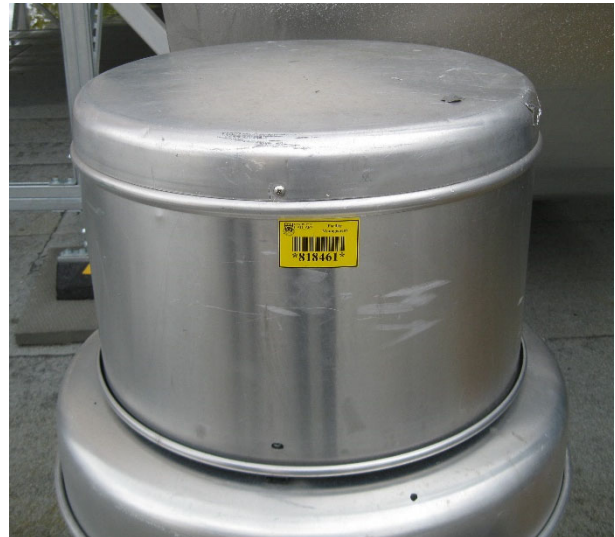
Example 6. Exhaust Fan
